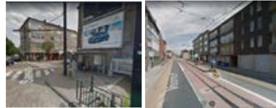
Links, de oude halte van tram 4. Rechts de nieuwe.
