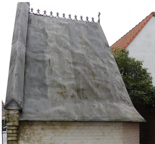
bolstaande zinkbekleding
