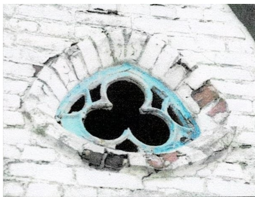
vroegere situatie met een gietijzeren raamframe
